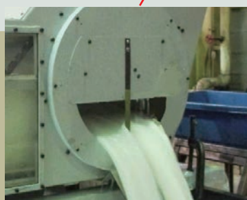
大口径排水口
