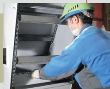
メンテナンスがしやすい ボトムパン開閉式
