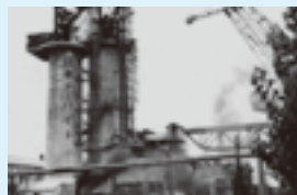
化学肥料工場向け搬送コンベヤ （バケットエレベータ）
