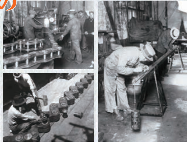
南浜工場での作業風景
