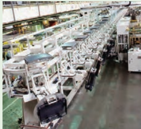
国内外家電メーカーに納入した ブラウン管搬送システム
