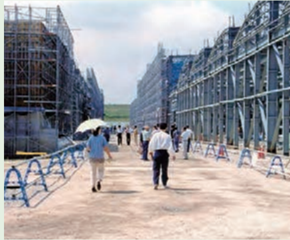
従業員家族向け新工場建設現場見学会
