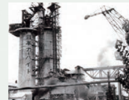
化学肥料工場のバケットエレベータ
