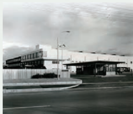
第1期工事が完了した京都工場
