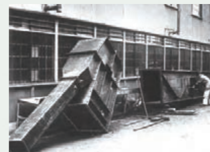
東北セメントに納入した初の大型コンベヤプラントのケース
