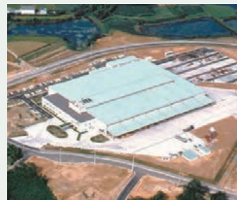
完成した兵庫工場全景
