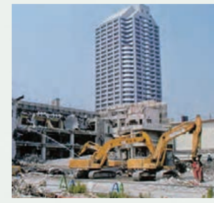
解体が進む本社工場
