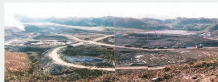
造成中の京田辺工場用地
