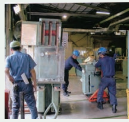
本社工場から京田辺工場への移転作業
