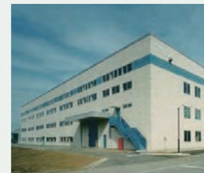
埼玉工場内の新テンション工場
