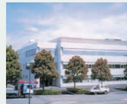
完成したコンベヤ技術センター
