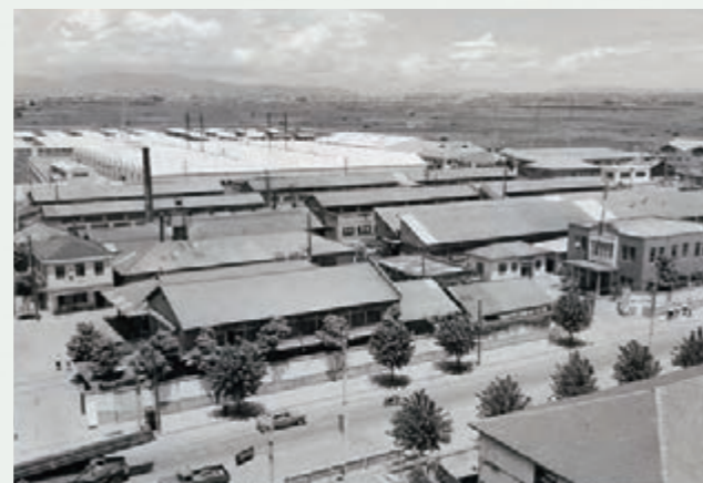
第1工場全景(奥の白い建物が新設ローラチェーン工場)
