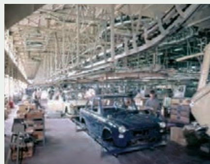
自動車ボディを搬送する「ノーマンカーブ」(天井走行コンベヤ)
