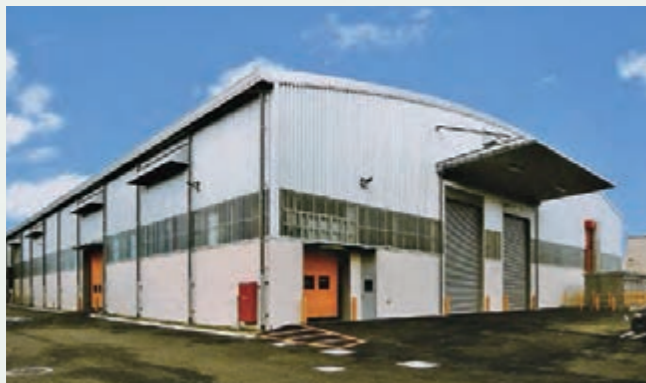
椿本鑄工の新鑄造工場
