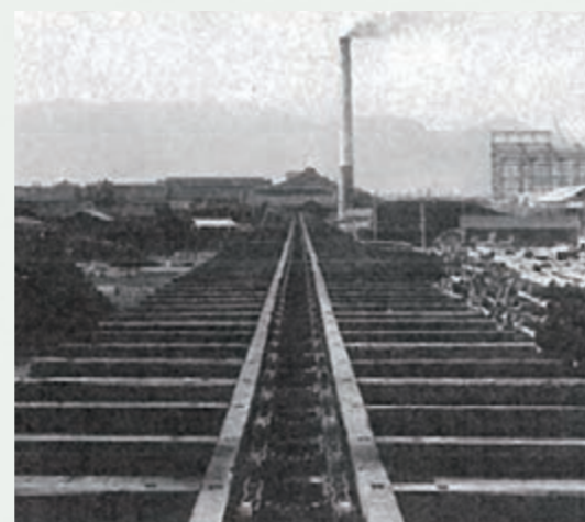
製紙工場の原木搬送用コンベヤチェーン
