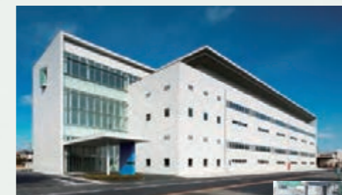
埼玉工場に竣工した新組立工場
