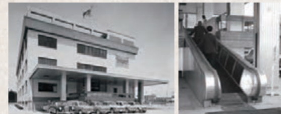
事務センター(左)と動く歩道
