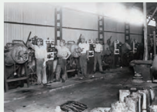
鶴見工場 熱処理工場
