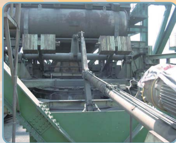
コークス乾式消火設備(CDQ)
