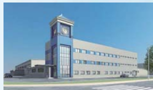
Tsubakimoto Chain (Tianjin) Co., Ltd.
