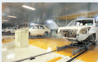
自動車塗装ライン搬送システム
