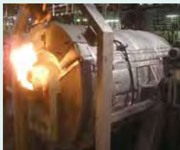
大型レトルト炉 断熱ジャケット取り付け
