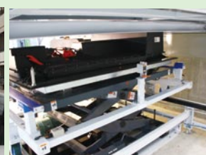
バッテリー交換作業
