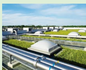
自動車技術棟の屋上緑化（埼玉工場）
